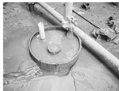
图4 下立交卸压孔冒水
