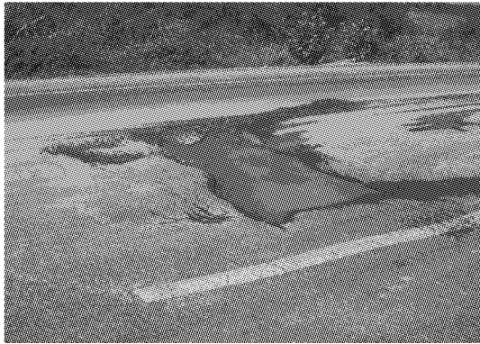
图 1 细砂路基局部沉陷
