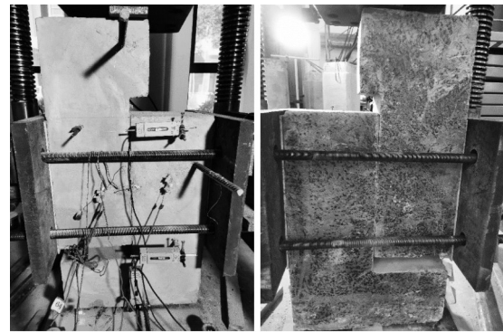
a 试件正面初始裂缝 b 试件反面初始裂缝
