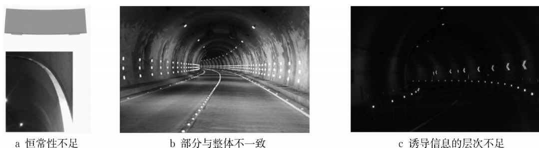
图2 小半径公路长隧道视觉环境典型问题
