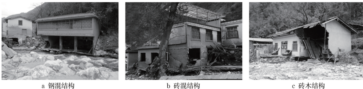
图6 不同类型建筑墙体破坏实例
