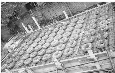
图3 EPS混凝土型块填充板(未浇混凝土)
