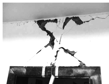
图 14 汶川地震中混凝土连梁的破坏
