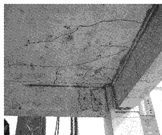
图3 现浇板裂缝
