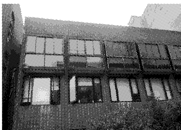
图 3 明成楼附楼西南立面实景
