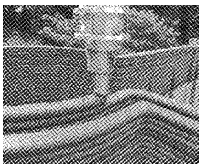
图 9 建筑墙体外轮廓的 3D 打印过程 [34]
