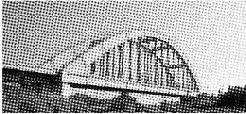
图 2 汀泗河特大桥 Fig.2 Dingsi Bridge
