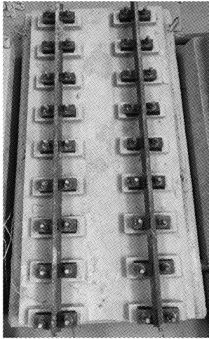
图5 钢轨、扣件安装
