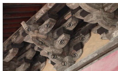
a 斗拱侧面照片
