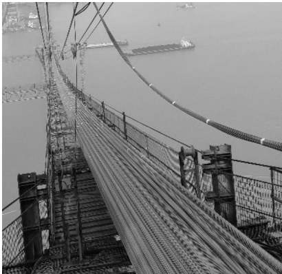
图3 主缆索股架设施工 Fig. 3 Erection construction of main cable strands
