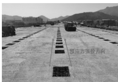
图6 浇筑负弯矩桥面板
