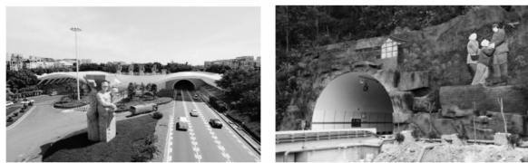
c 厦门翔安隧道洞口
