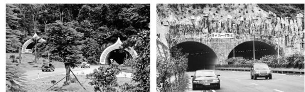
a 野象谷隧道洞口
