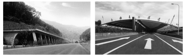
a 南京老山隧道洞口 b 上海长江隧道洞口
