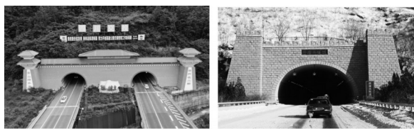
a 二郎山隧道洞口
