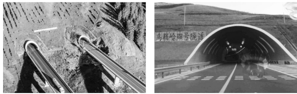
a 新疆赛里木湖隧道洞口 b 乌鞘岭四号隧道洞口
