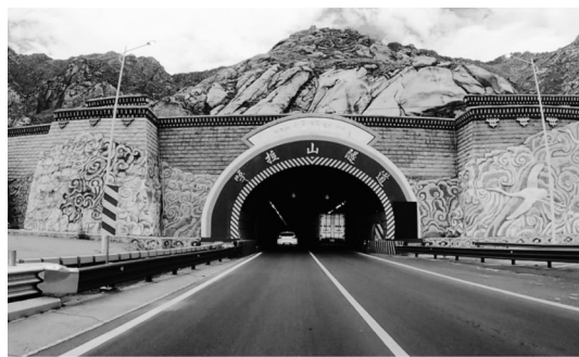
图2 嘎拉山隧道洞口
