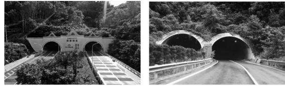
a 南腊隧道洞口 b 蝴蝶兰隧道洞口
