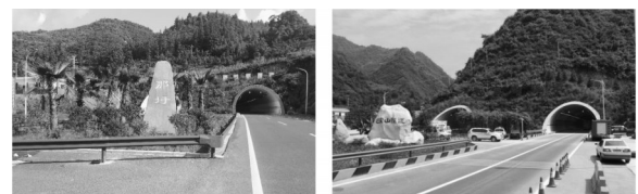
a 那圩隧道洞口
