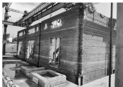
b 3D 打印粗骨料混凝土建筑
