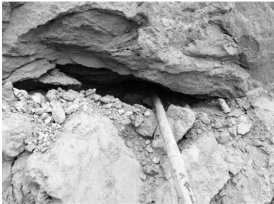
图 9 回填土层小空洞发育照片
