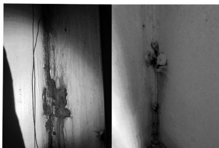
b 钢桥塔中的角焊缝腐蚀 [63]
