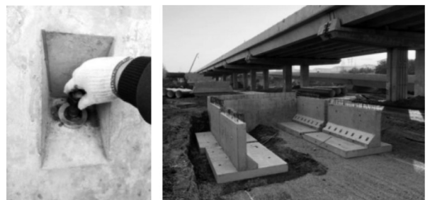
a 螺栓安装
