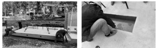
a 预制底板吊装
