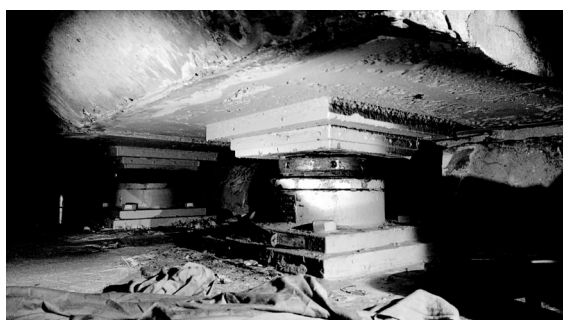
图 14 上海高速磁浮示范线线形优化调整支座情况
