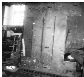
图4 钢板安装照片 Fig.4 Installing steel plate
