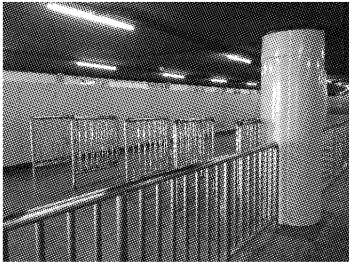
图1 上海市曹杨路站11号线转3号线、4号线换乘通道中的栏杆
