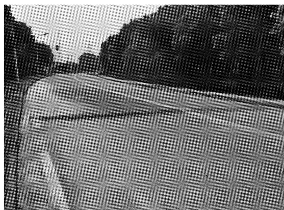
图 3 试验环道中的沥青路面局部异常凸起 Fig.3 Abrupt bulge in the test loop road
