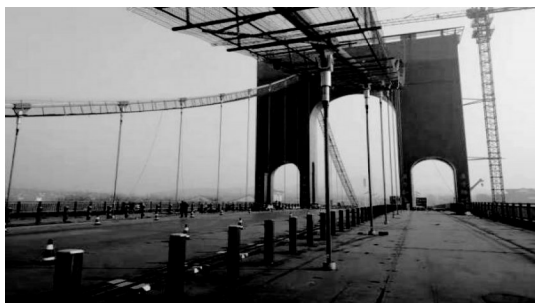
图7 吊杆张拉完成
