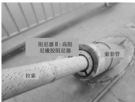
图3 安装双阻尼器的拉索
