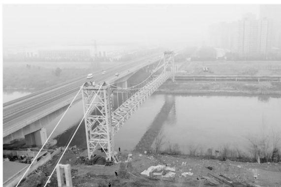
图5 主缆成桥状态
