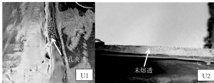
图 6 试件焊接缺陷
